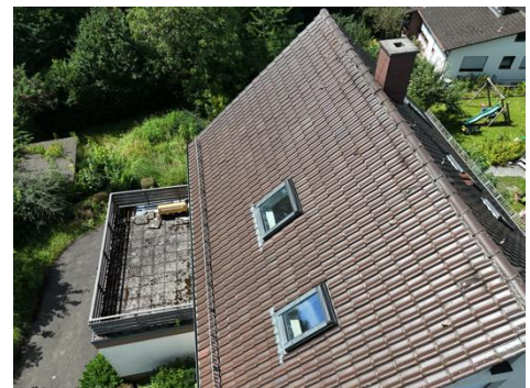
Dach- & Fassade vorne abgeschnitten
